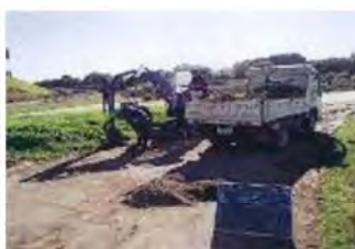
越流後の堆積土の除去作業
