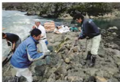
水寄せの修理
